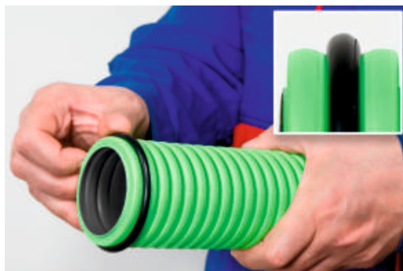
2) Do 1. drážky nasadíme těsnící „O“ kroužek.
