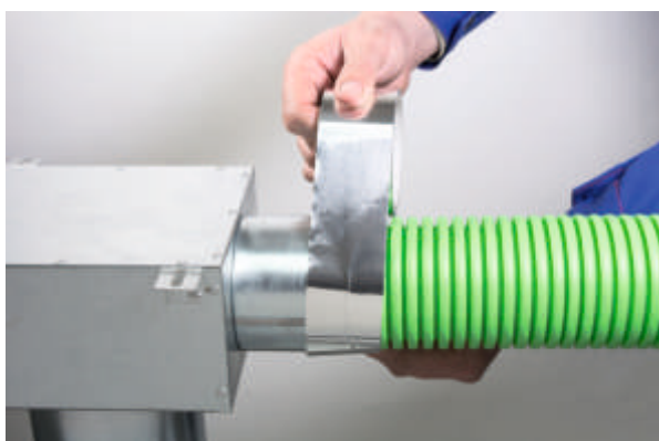
7) Spoj zajistíme vzduchotěsnou lepicí páskou.
