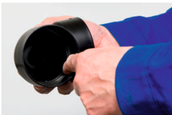
5) Vnitřní povrch kolena namažeme kluzným přípravkem*.
